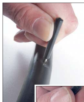
Mit der Spitze des Montageschlüssels wird an der gewünschten Stelle ein Loch in den Wasserstrang gestochen
